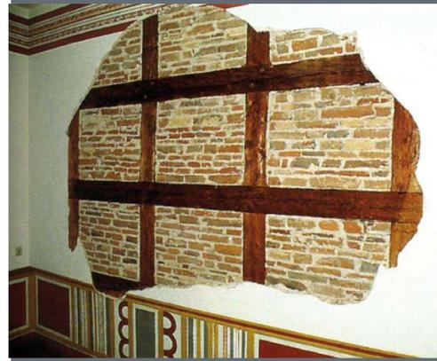
Wandaufbau aus ausgemauertem Fachwerk - Demonstration römischer Bautechnik (römischer Vicus/Dorf von Homburg-Schwarzenacker im Saarland).
